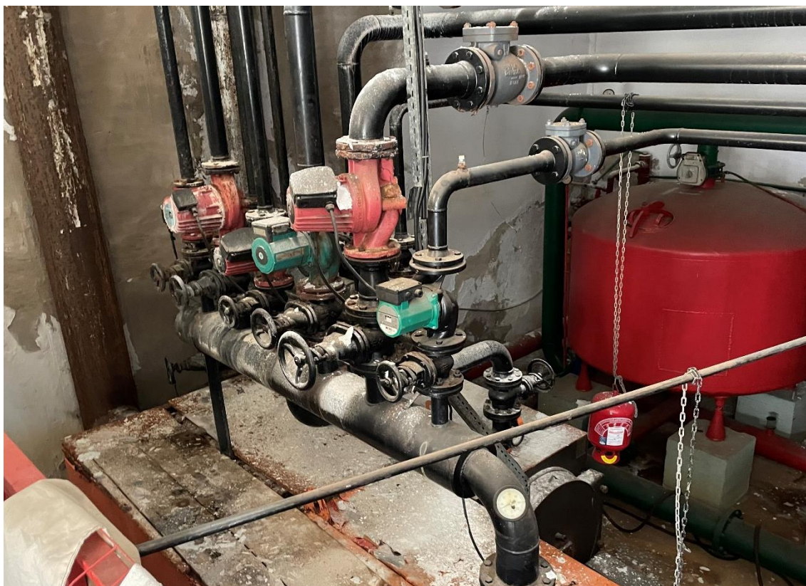
Εικόνα 2.4.9 Διανομέας λεβητοστασίου
