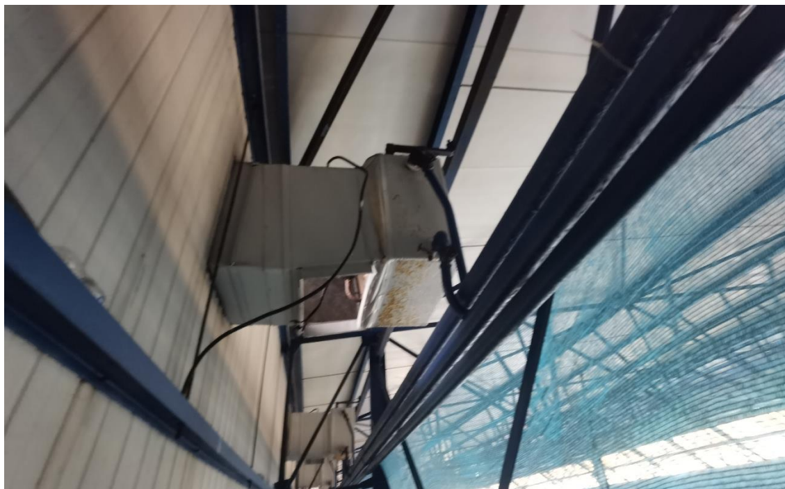
Εικόνα 3.4.2 Ενδεικτική στήριξη αξονικών αερόθερμων
