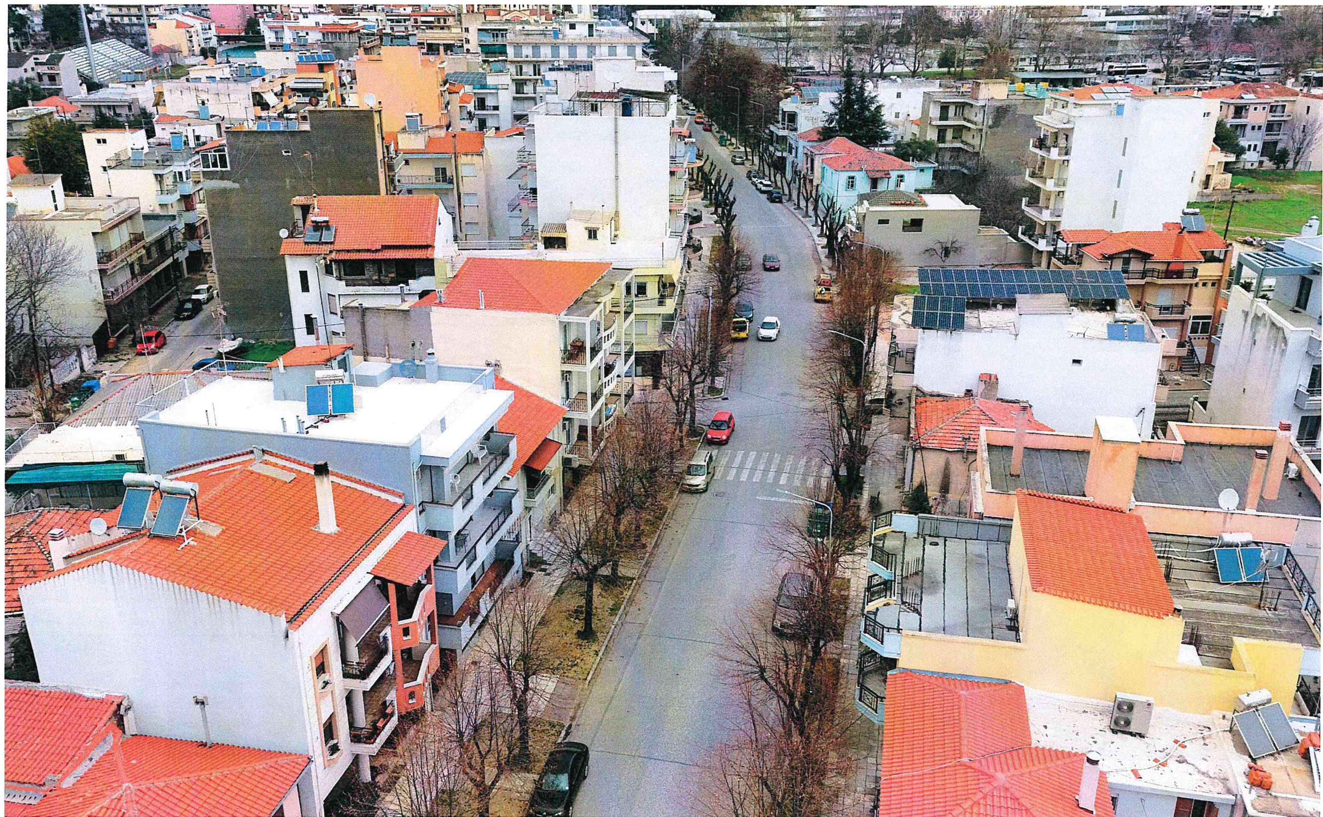
Οδός Τσαλδάρη. Αεροφωτογραφία Ν-Β
